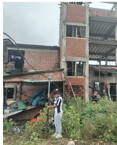
Replanteo de lotes urbanos
