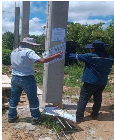
Paralizacion de Construccion
